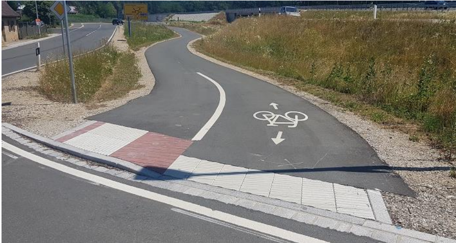
Abbildung 16: Sofern auf eine Materialkante nicht verzichtet werden kann, ist eine Kombination aus Nullabsenkung und Bordkante möglich. Die Absenkung sollte deutlich markiert und der gesamten Breite des kombinierten Geh- und Radwegs entsprechen. An der Querungsstelle für Blinde und Sehbehinderte sollte der Geh- und Radweg entsprechend aufgeweitet werden (abweichend vom Fotobeispiel).
