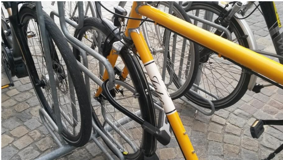
Abbildung 34: Ständer mit Kippschutz, aber zu kurzem AnschlieÙbügel. Der Fahrradrahmen kann mit einem herkömmlichen Schloss nicht angeschlossen werden.
