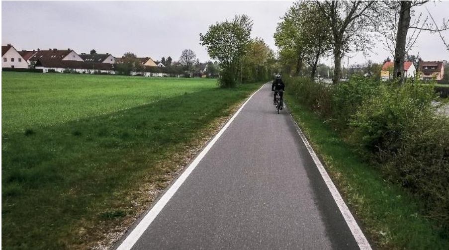
Abbildung 39: Weiße Randmarkierung auf einem außerörtlichen Radweg
