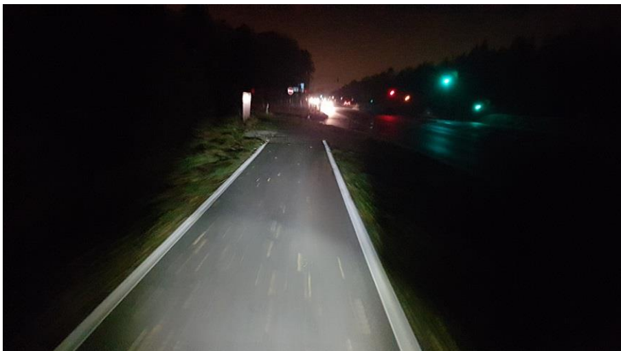
Abbildung 17: Eine weiße Randmarkierung erhöht die Erkennbarkeit der Verkehrsführung gerade bei Dunkelheit erheblich.
