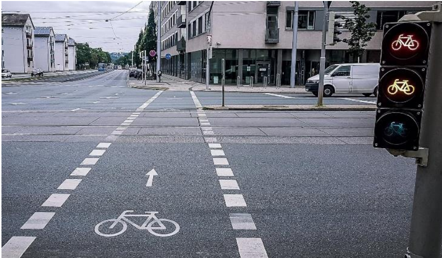
Abbildung 38: Installation von Signalgebern für den Radverkehr
