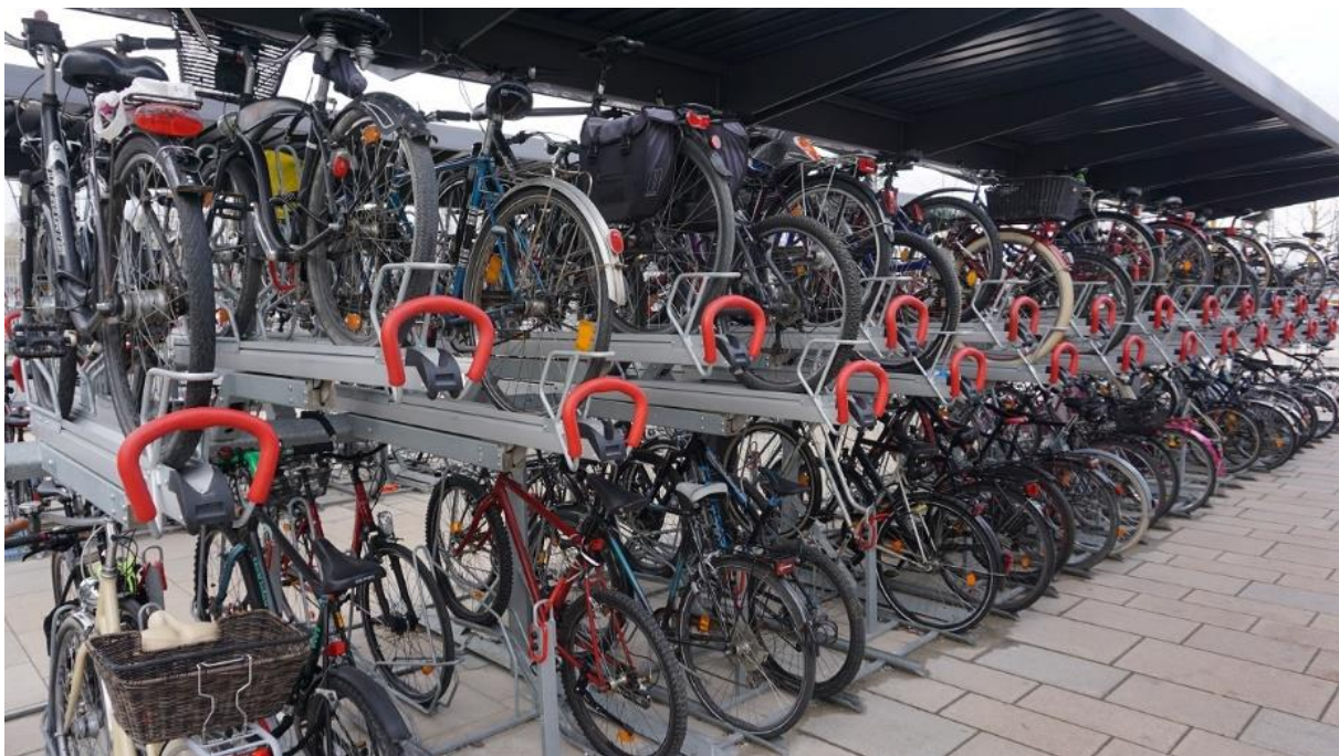
Abbildung 36: Doppelstockparksystem mit Witterungsschutz
