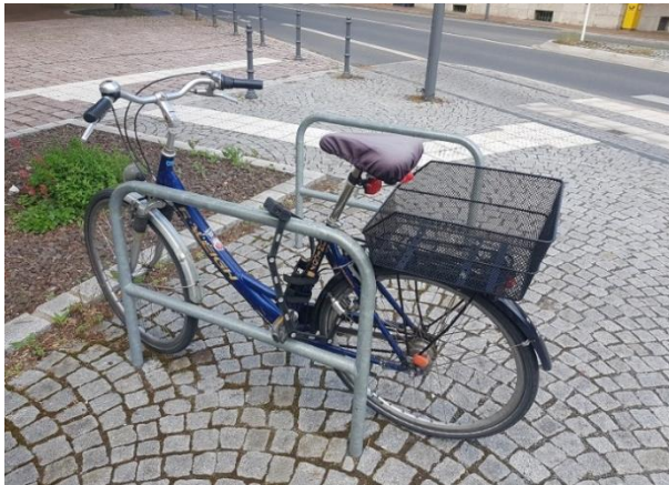
Abbildung 35: Anlehnbügel mit Querholm, Ausführung Rundrohr (links), Abstände von Anlehnbügeln bei Doppelaufstellung (rechts)
