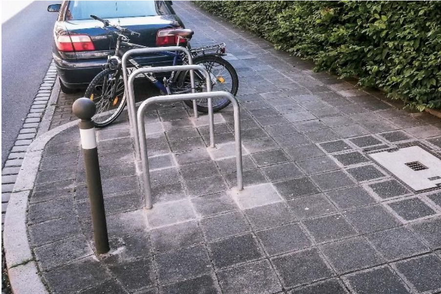
Abbildung 33: Radanlehnbügel im Straßenraum in einem Wohngebiet
