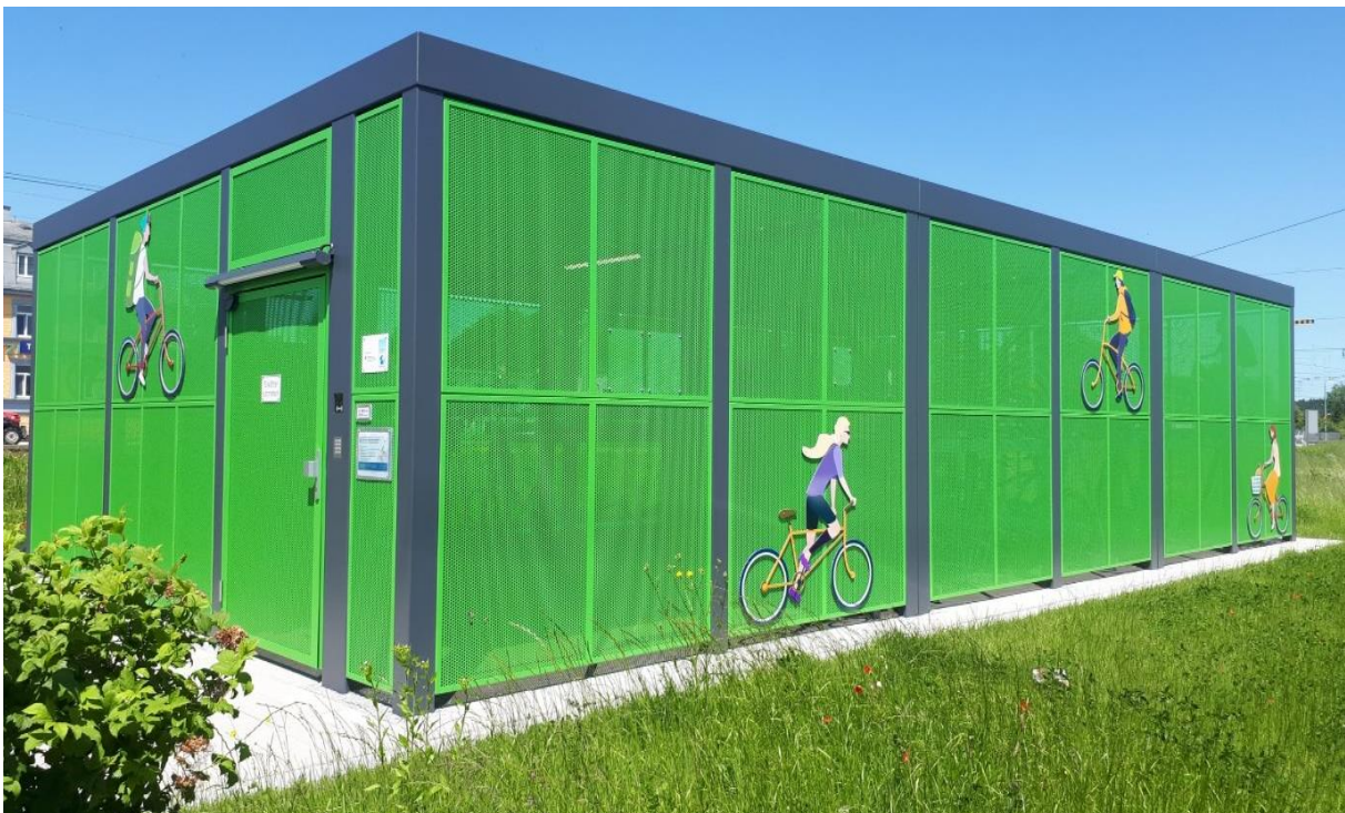
Abbildung 23: Sammelschließanlage mit elektronischer Zugangskontrolle
